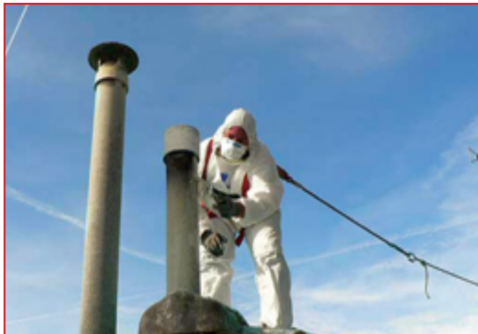
Operatore per la rimozione dell'amianto
