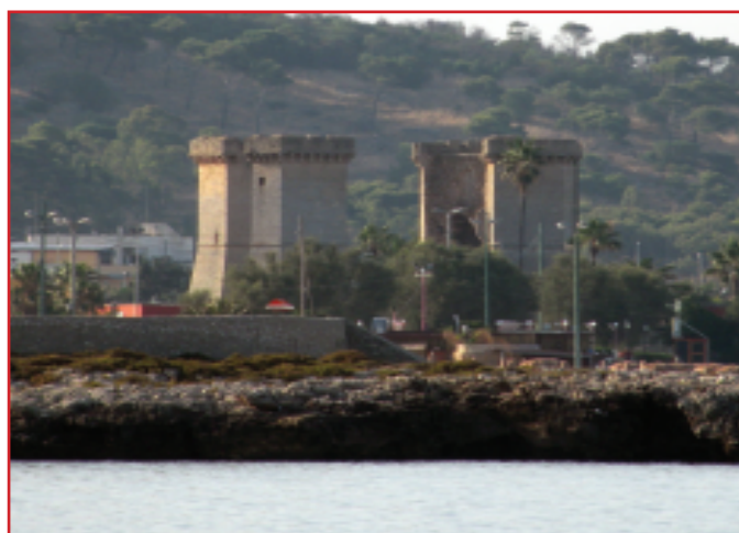
Nardò (LE) - Santa Maria al Bagno - Torre del Fiume
